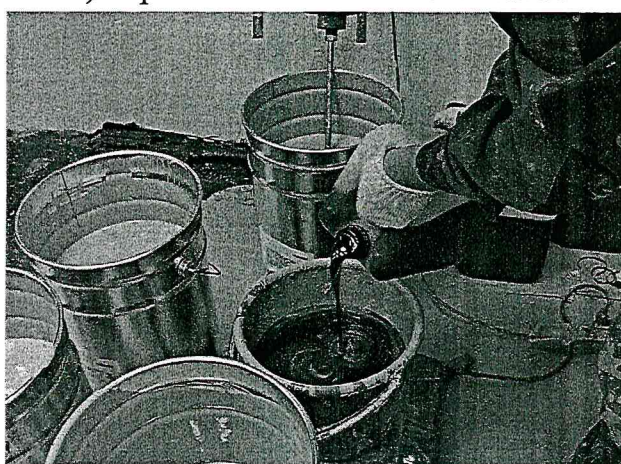
г) дозировка компонента В
