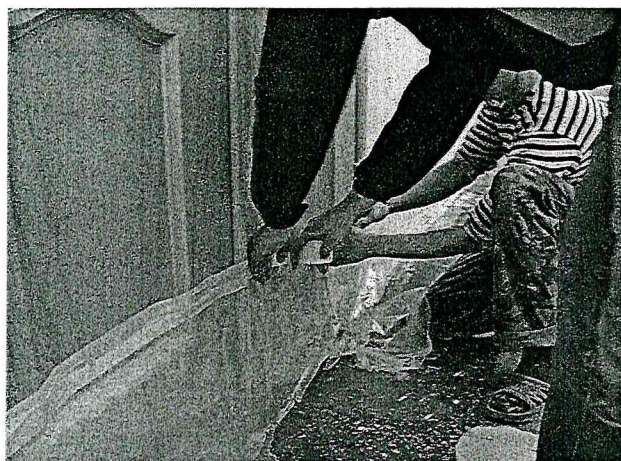
а) наклеивание полиэтиленовой пленки
