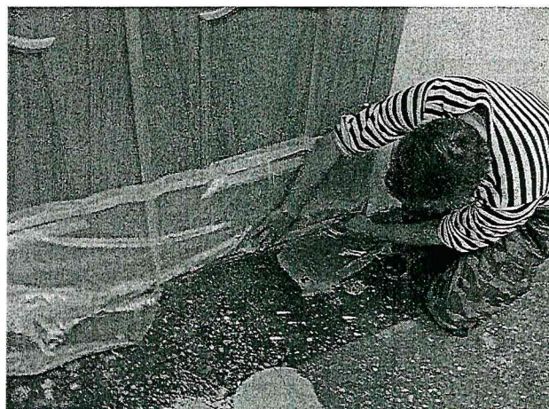
б) обрезка полиэтиленовой пленки
