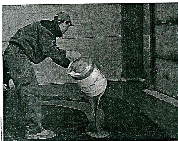
а) нанесение композиции
