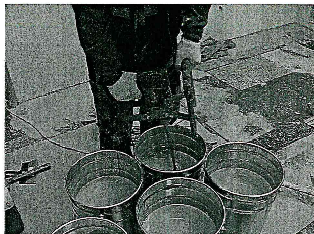
б) перемешивание компонента А
